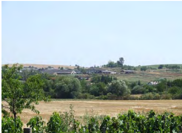
9. ábra: A szántóhoz kapcsolódó rossz állapotú gazdasági épületcsoport
