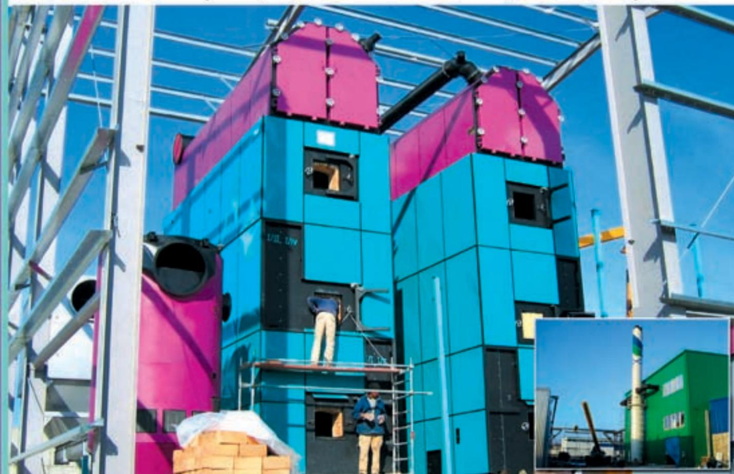
«ЛЕСОБАЛТ» 3x6.000 кВт котельная с гидравлическими механическими колосниковыми решетками
